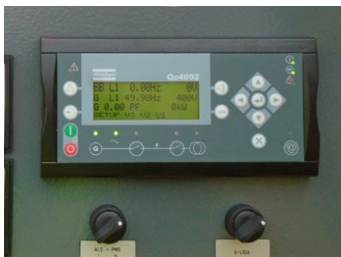
Панель управления с возможностью синхронизации работы (опционально)
